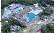
Washizu Plant / 鷺津工場
